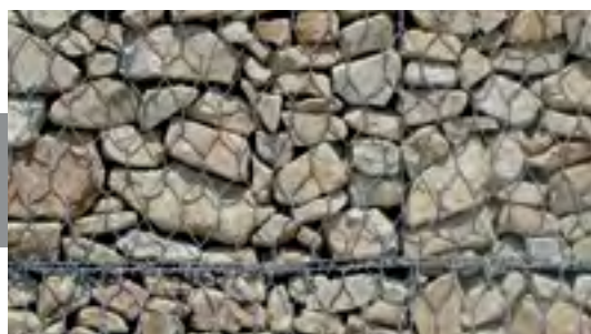
Čelo z pletených gabionov »
