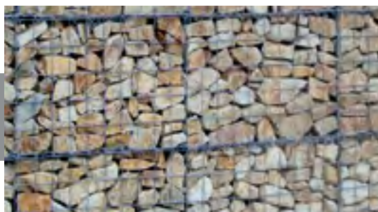
Čelo zo zváraných gabionov »
