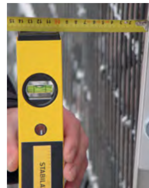
« Kontrola a meranie sklonu čela gabionovej konštrukcie
