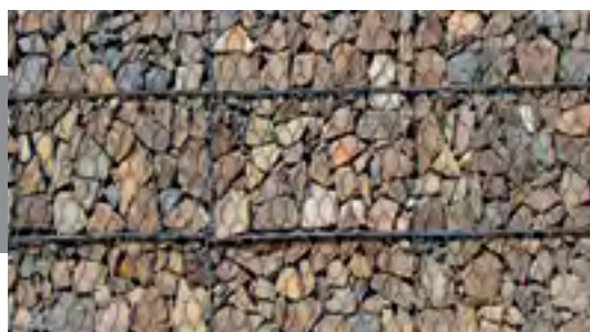
» Príklad kvalitne vyloženého čela gabionu. Kamenivo v čele aj medzerovitost' sú optimálne.
